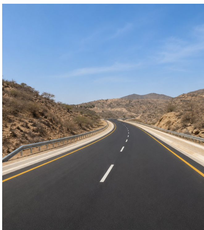
Via concluída com sinalização, drenagem e acabamentos finais.
